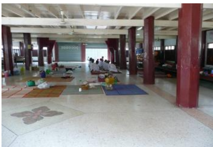
ภาพประกอบ 55 โครงสร้างช่วงล่าง ที่มีเสาคอนกรีต คาน ตงและพื้นไม้ชั้นบน ส่วนพื้นชั้นล่างเป็นพื้นคอนกรีตทำผิวขัดมัน
