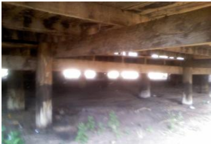
ภาพประกอบ 68 เสา คาน ตงและพื้นไม้
