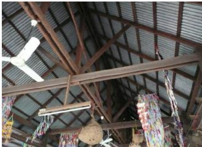
ภาพประกอบ 114 โครงสร้างช่วงบน ประกอบด้วย ไม้ค้ำ ไม้เสียดัง จันทันและแป
