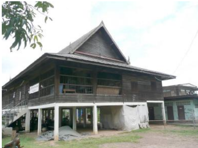
ภาพประกอบ 77 ผนังส่วนโปร่งเป็นไม้ซ้อนเกล็ดทางนอนสูงประมาณ 1.10 เมตร ส่วนบนเป็น ลูกกรงเหล็กผนังส่วนทึบเป็นไม้ซ้อนเกล็ดทางนอน
