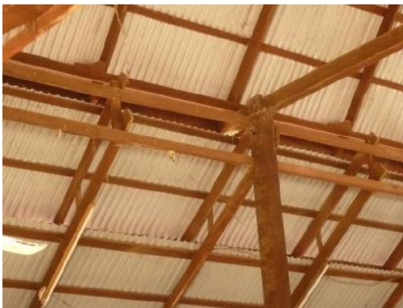
ภาพประกอบ 96 พุกไม้ที่ยึดระหว่างจันทันเพื่อทำหลังคาเป็น 2 ชั้น
