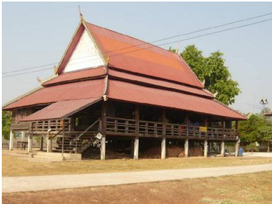
ภาพประกอบ 92 รูปทรงของหอแจก จะเห็นว่าชายคาที่ยื่นออกมาทำเป็น 2 ชั้น
