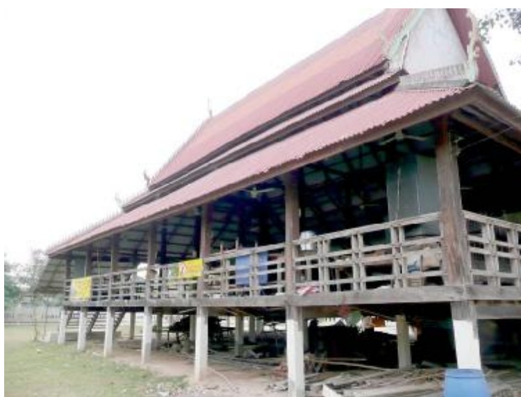
ภาพประกอบ 97 โครงสร้างช่วงล่าง มีเสาคอนกรีตสูงถึงคาน โครงสร้างส่วนอื่นเป็นไม้
