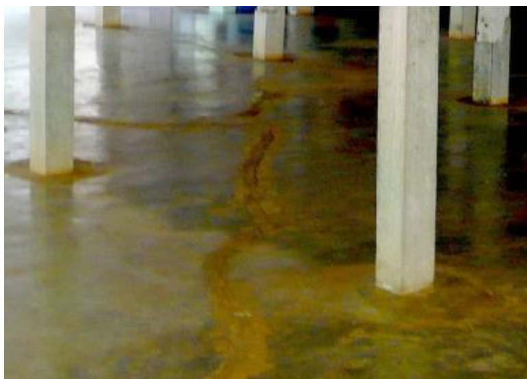
ภาพประกอบ 134 การต่อเติมครั้งที่ 2 เป็นการขุดพื้นลงไปและทำการเทพื้นคอนกรีต
