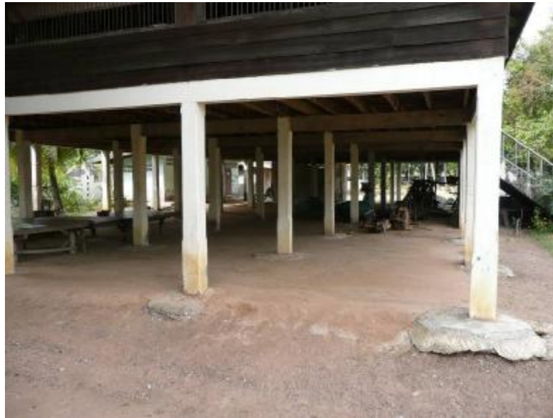
ภาพประกอบ 78 โครงสร้างช่วงล่างเป็นเสาและคานคอนกรีต
