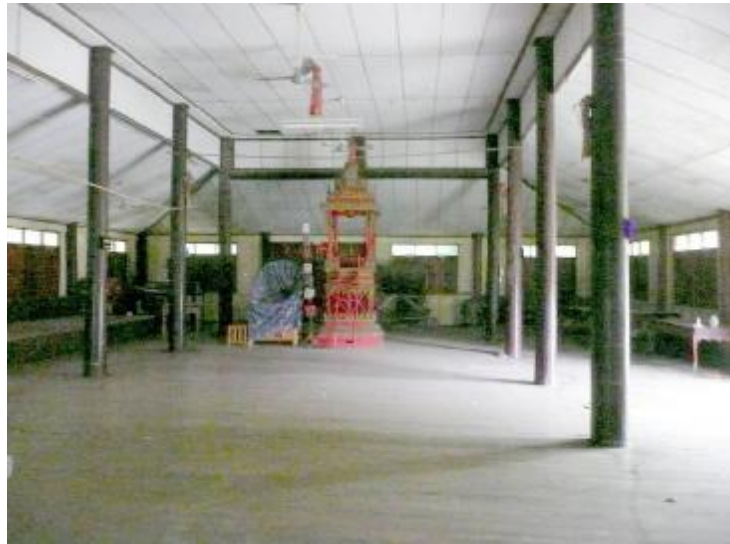
ภาพประกอบ 62 โครงสร้างช่วงบน โดยมีเสาไม้ขึ้นไปรับโครงหลังคาไม้ และได้ทำฝ้าเพดานไม้ปิดเอาไว้
