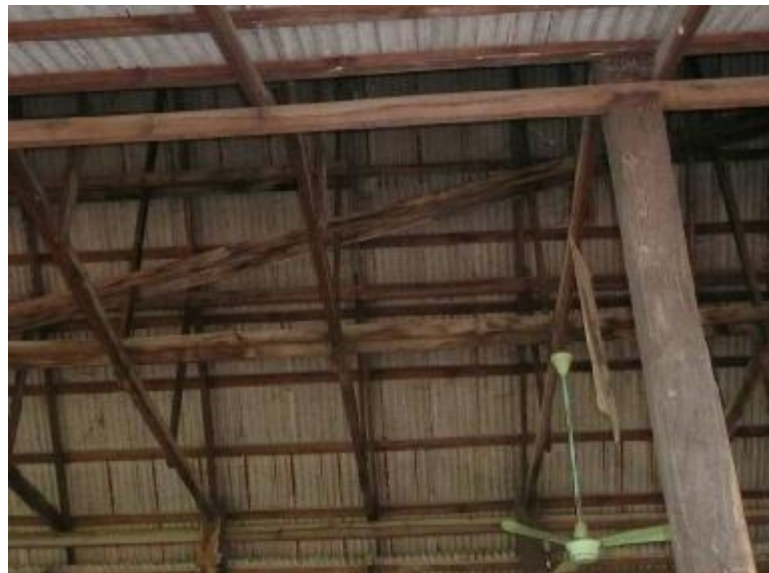
ภาพประกอบ 79 โครงสร้างช่วงบนเป็นเสาไม้ ชื่อ อะเส ชื่อ ดั้ง ออกไก่ จันทันและแป โดยมุงหลังคาด้วยสังกะสี
