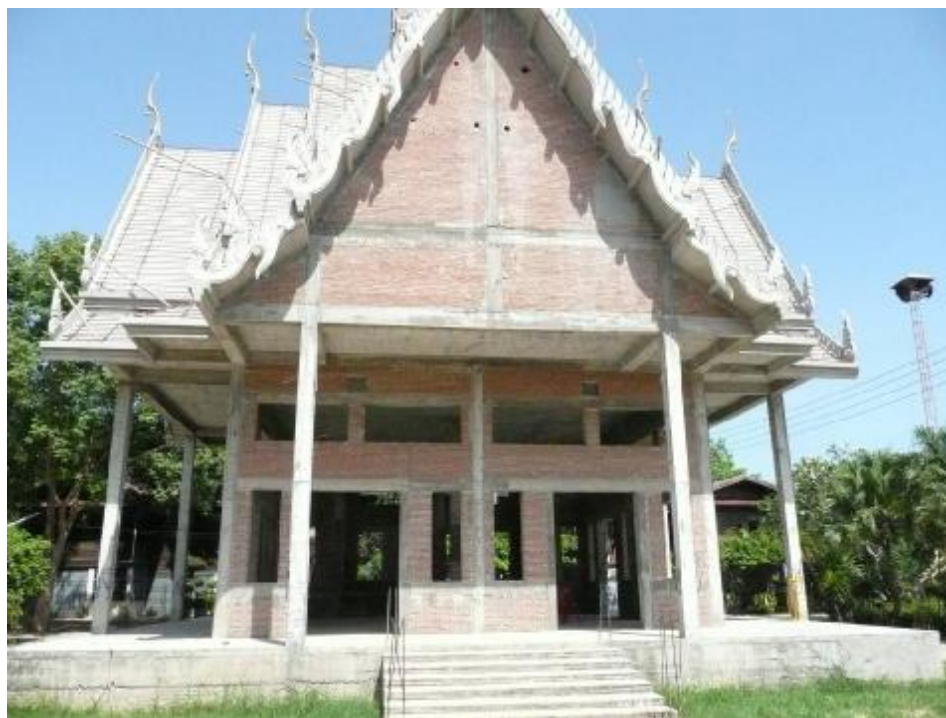
ภาพประกอบ 14 วิหารบูรพาจารย์(กำลังก่อสร้าง)
