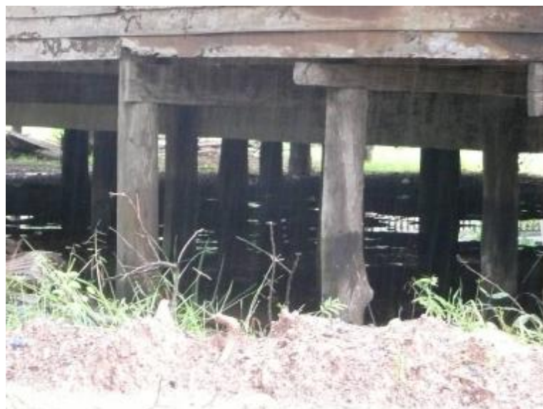
ภาพประกอบ 67 โครงสร้างช่วงล่าง ประกอบด้วยเสาไม้ คานไม้ ตงไม้
