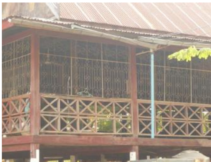
ภาพประกอบ 87 ผนังโปร่งที่เป็นลูกกรงสูงประมาณ 1.10 เมตร ส่วนบนเป็นลูกกรงเหล็กดัดสูงถึงอะเส
