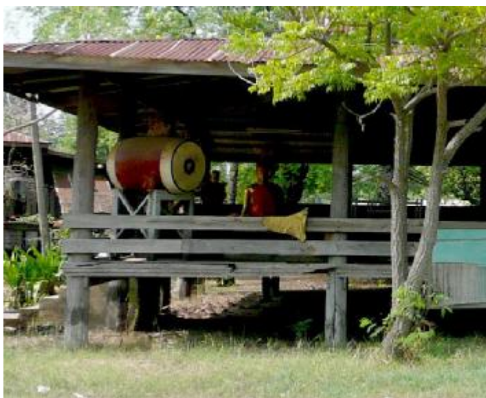
ภาพประกอบ 129 การนำไม้แผ่นมาติดตั้งไว้แทนลูกกรงไม้
