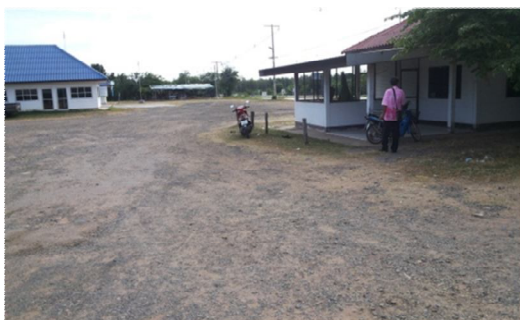
4.5 (3) ทางเข้าและลานจอดรถด้านหลัง
