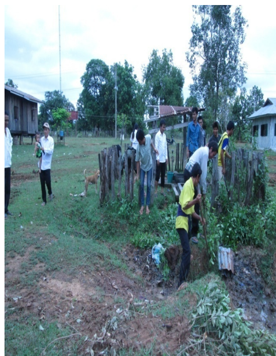
ภาพประกอบ ญ.6 การขุดคลองระบายน้ำ
