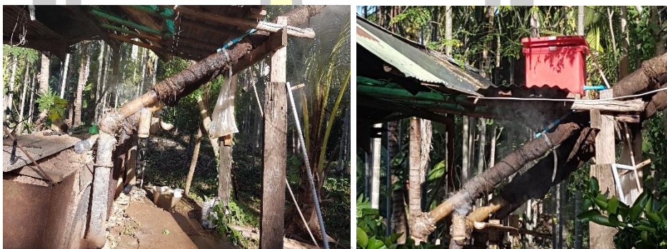
ภาพประกอบ 15 การติดตั้งระบบหล่อเย็นแบบน้ำหยด
