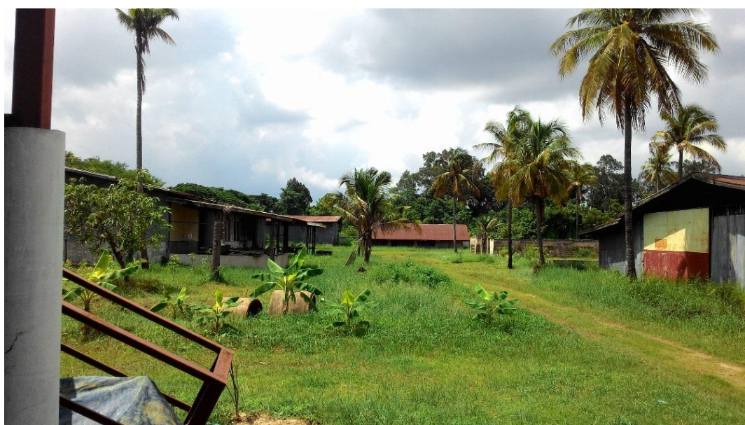
ภาพประกอบ 76 บริเวณโดยรอบโรงงานคูลิ่ง (ถ่ายภาพเมื่อวันที่ 10 ตุลาคม 2559)
