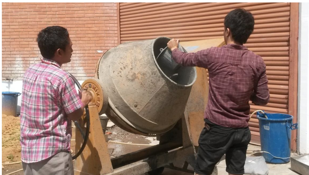
ภาพประกอบ จ.3 การผสมส่วนประกอบของคอนกรีต
