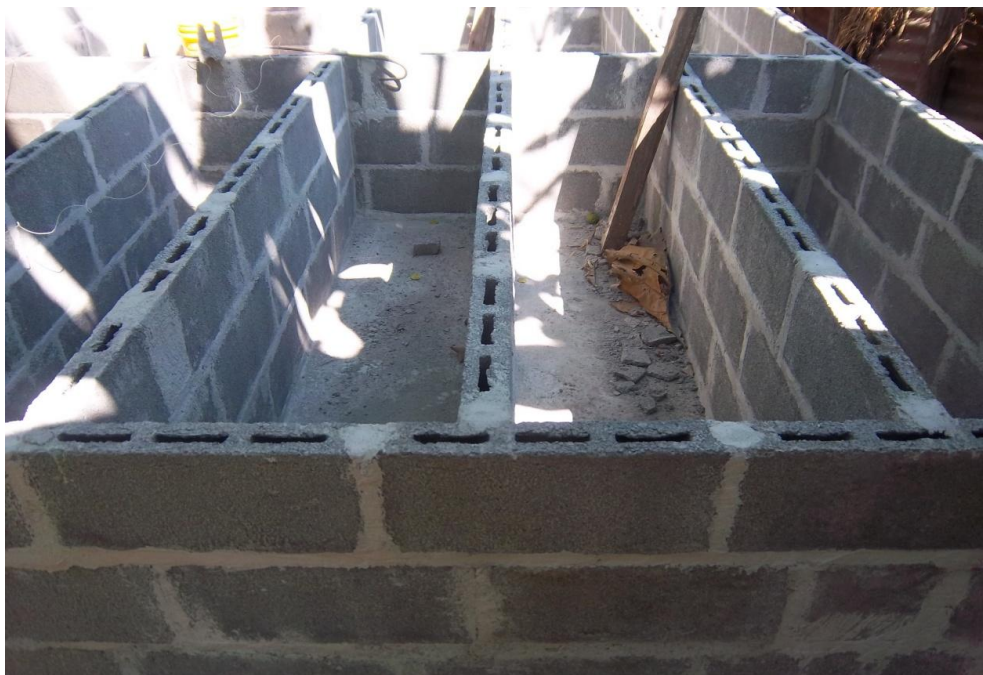
ภาพประกอบภาคผนวก ข.11 การสร้างบ่อทดลอง
