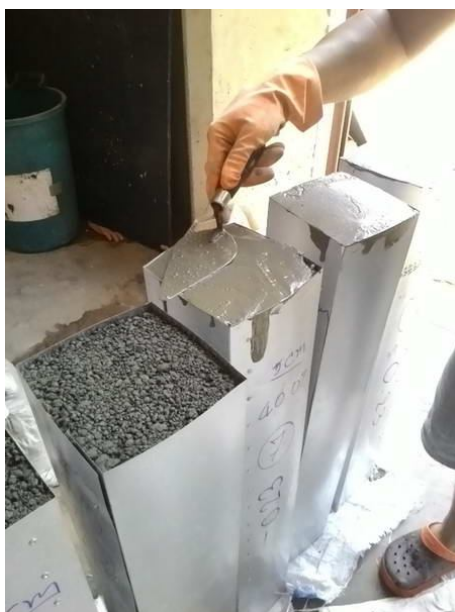
ภาพประกอบ 3.7 การกรอกคอนกรีตบดล็อกลงในเสาประกอบ
