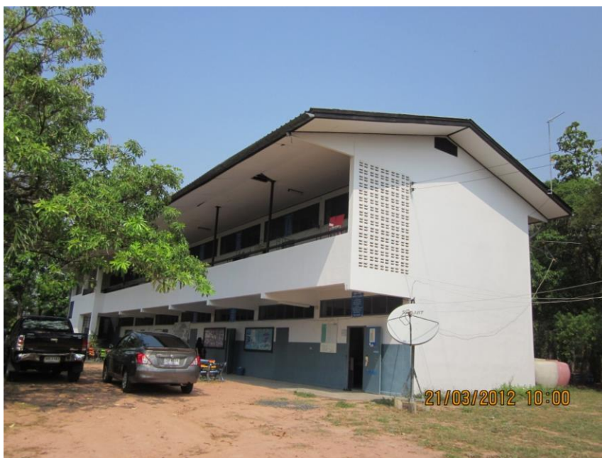
ภาพประกอบ 8 อาคารเรียนโรงเรียนบ้านโคกล่าม ตำบลบรบือ อำเภอบรบือ จังหวัดมหาสารคาม
