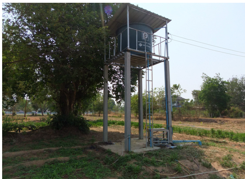
ภาพประกอบ 14 การเจาะบ่อบาดาลเพื่อนำน้ำมาใช้ในพื้นที่ทดลอง
