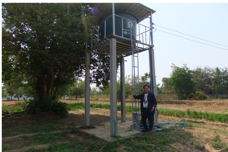
ภาพประกอบ 48 การติดตั้งเครื่องสูบน้ำในบ่อบาดาลเพื่อส่งน้ำไปยังแปลงปลูกสมุนไพรม
