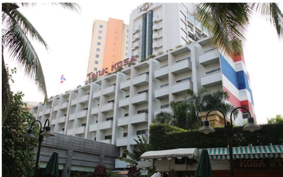
ภาพประกอบ 10 อาคารห้องพักโรงแรมໂພຂະ จังหวัดขอนแก่น
