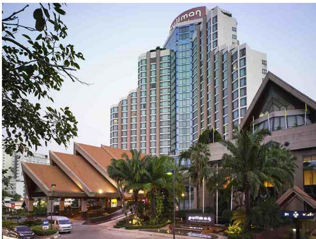
ภาพประกอบ 13 อาคารห้องพัก โรงแรมพูลแมนขอนแก่น ราชารอคิด
