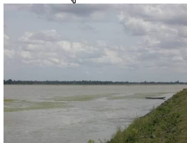
สภาพทั่วไปอ่างเก็บน้ำบึงเกลือ
