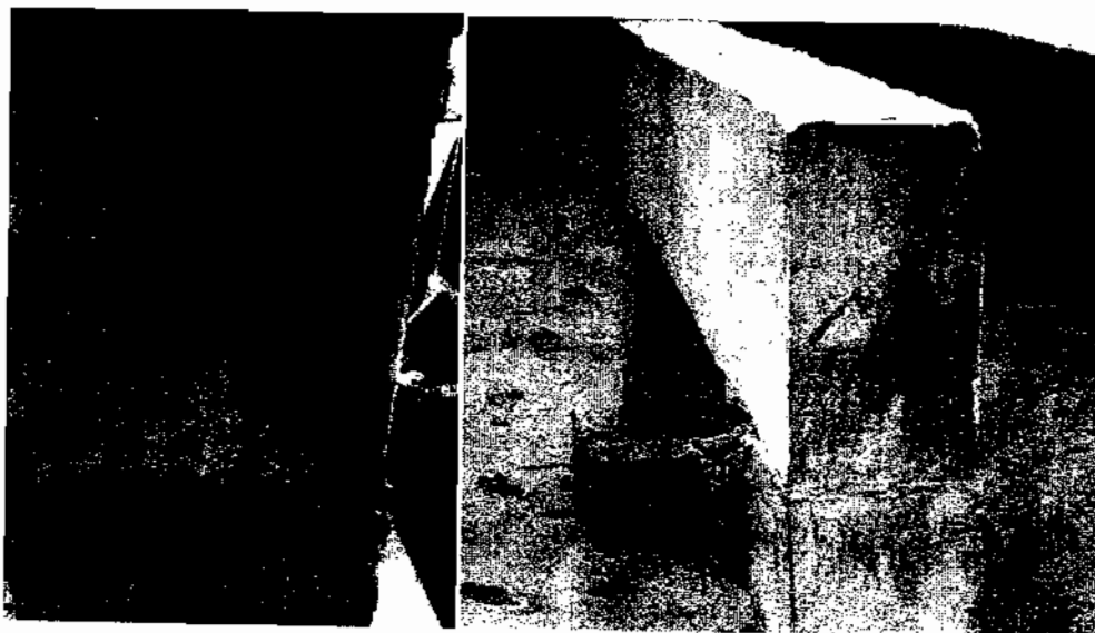
ภาพประกอบ 4-9 การแตกหักที่หัวเสาของโครงสร้างหล่อในที่
