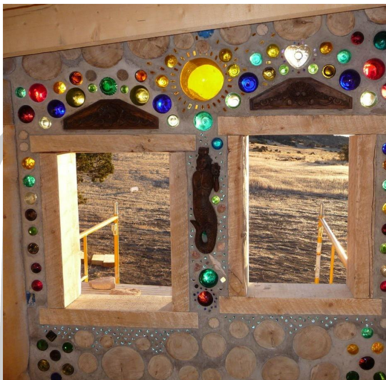
ภาพประกอบ 18 การตกแต่งผนังด้วยขวดแก้วเพื่อเพิ่มความสวยงามและนำพาแสงสว่างเข้าสู่ภายใน บ้านดินที่มา: http://www.baandin.com/:2551 (Online)
