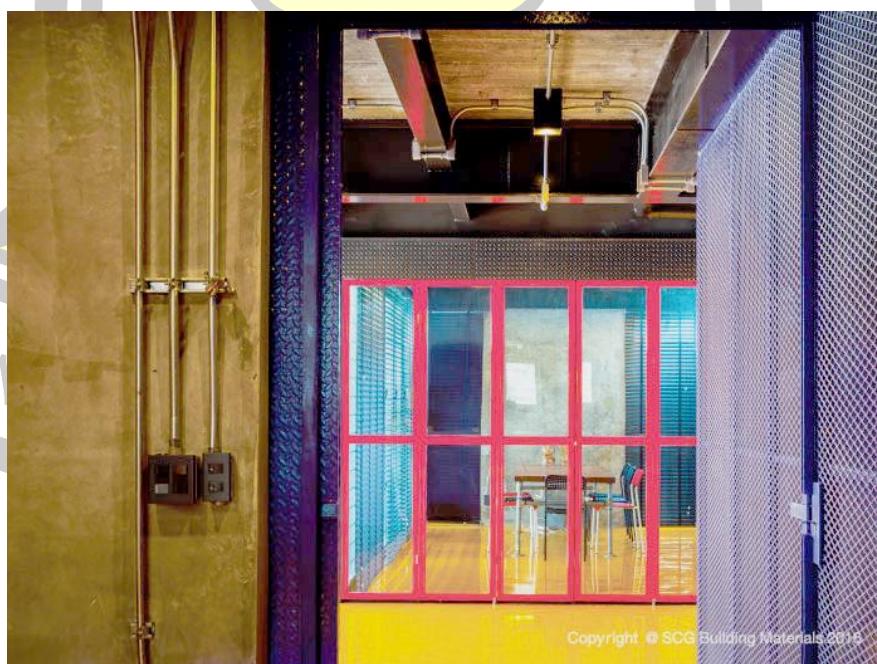
ภาพประกอบ 72 ภาพการเดินแบบท่อลอยเพื่อเป็นการตกแต่งบ้าน
