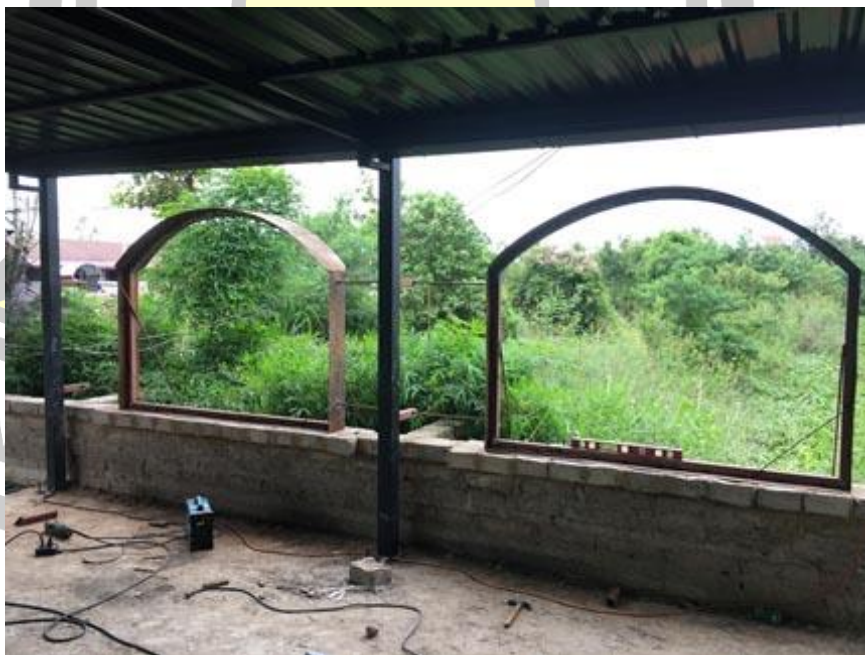
ภาพประกอบ 112 ภาพการก่อดินทำผนังและขึ้นวงกบหน้าต่าง
