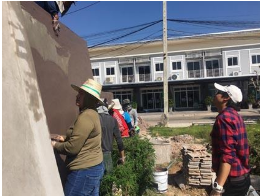
ภาพประกอบ 115 ภาพการฉาบตกแต่งผนังด้วยดินสี
