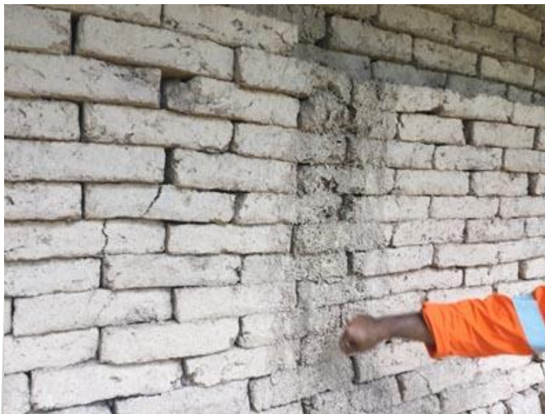
ภาพประกอบ 30 ภาพอิฐดินที่โดนน้ำกัดเซาะ
