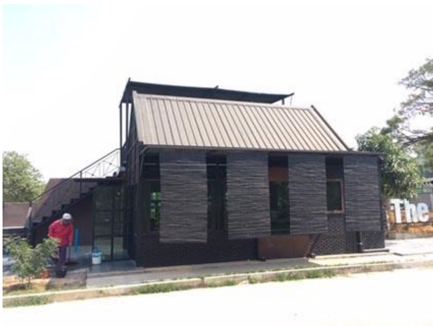
ภาพประกอบ 94 ภาพด้านข้างขวามือบ้านดินแบบประยุกต์(apply) ระหว่างดำเนินการสร้าง
