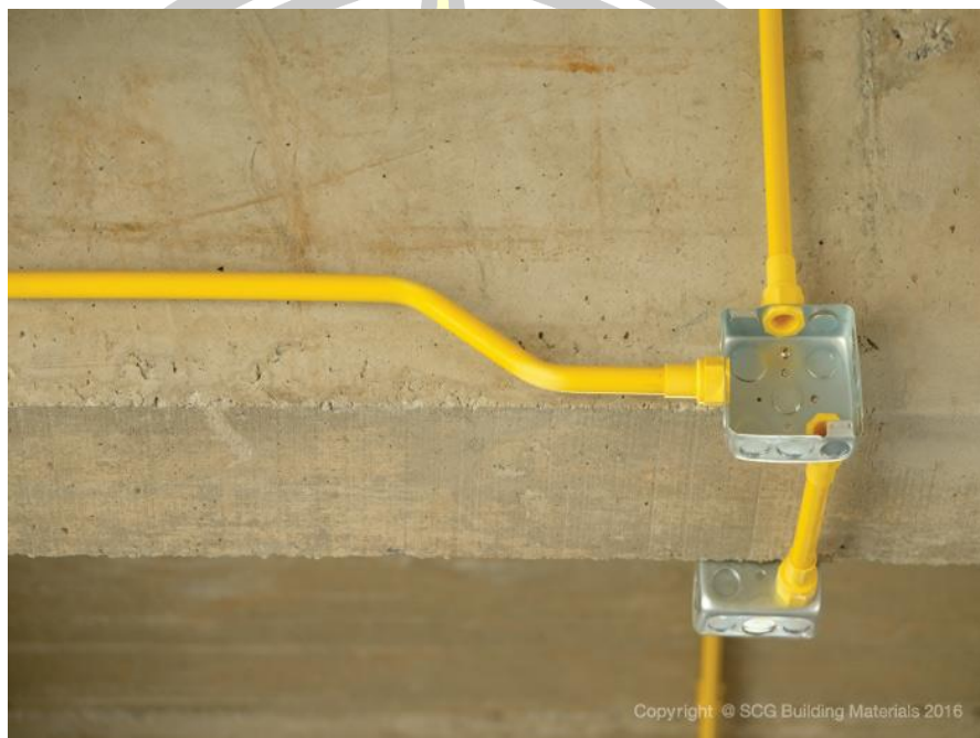
ภาพประกอบ 71 ภาพตัวอย่างการเดินระบบไฟฟ้าแบบลอย
