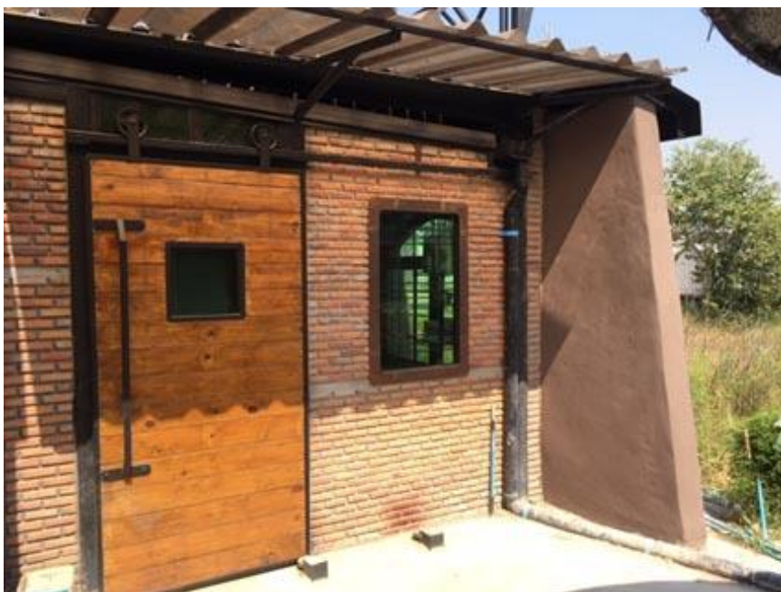
ภาพประกอบ 96 ภาพด้านหลังบ้านดินแบบประยุกต์(apply) ระหว่างดำเนินการสร้าง
