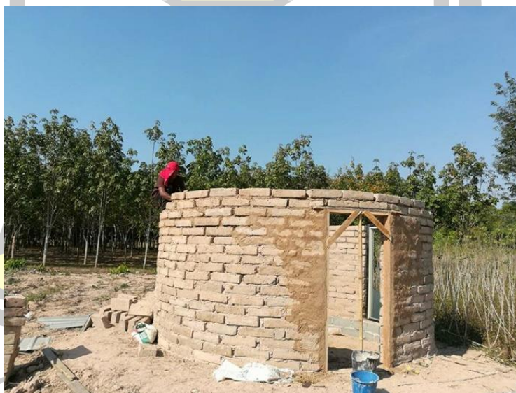
ภาพประกอบ 63 ภาพนำก้อนดินมาก่อเป็นบ้านดิน
