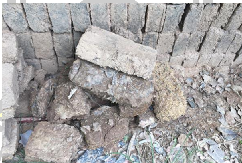
ภาพประกอบ 29 ภาพอิฐดินที่โดนน้ำกัดเซาะ
