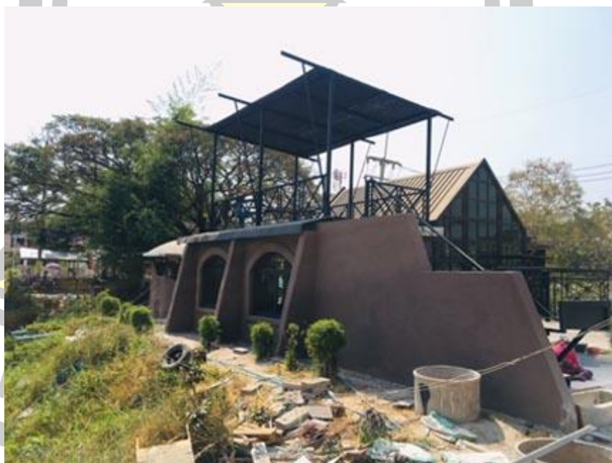
ภาพประกอบ 93 ภาพด้านข้างซ้ายบ้านดินแบบประยุกต์(apply) ระหว่างดำเนินการสร้าง
