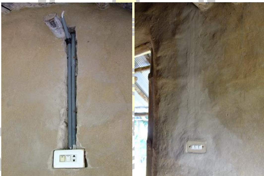
ภาพประกอบ 70 ภาพใส่บล็อกสวิตช์/ปลั๊กแล้วจึงฉาบปิดตกแต่งผนัง
