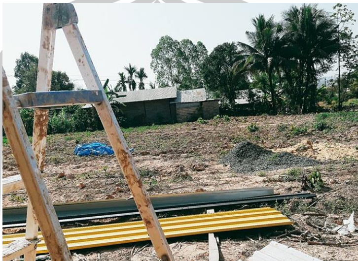
ภาพประกอบ 62 บริเวณพื้นที่สำหรับสร้างบ้านดิน
