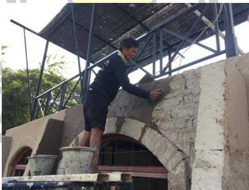
ภาพประกอบ 114 ภาพการฉาบผนังด้วยดิน
