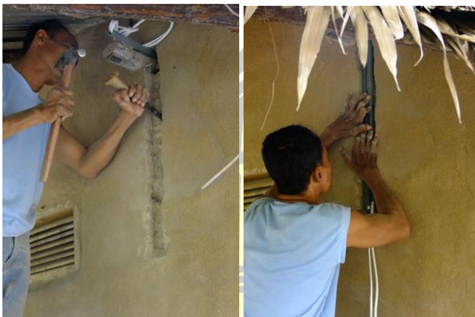
ภาพประกอบ 69 ภาพการผ่าผนังเพื่อฝังท่อร้อยสายไฟแบบฝัง
