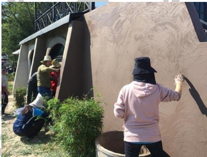
ภาพประกอบ 116 ภาพการฉาบตกแต่งผนังด้วยดินสี
