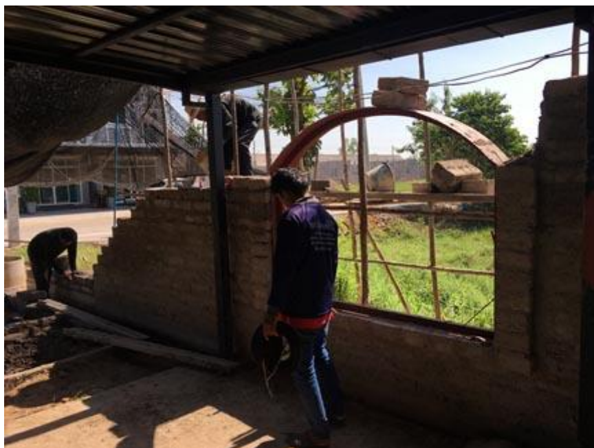
ภาพประกอบ 113 ภาพการก่อดินทำผนังและยึดวงกหน้าต่าง
